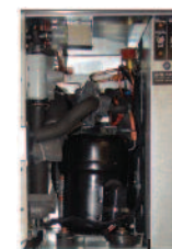
Compartimento seco del compresor y el sistema eléctrico
